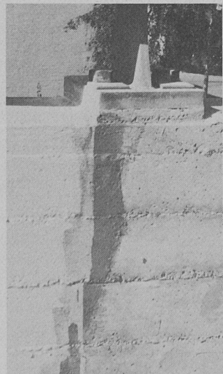
Trois phases différentes des travaux pour la protection des constructions en béton contre l'agression du sel de dégel. A droite, parapet en béton nettoyé. Au centre, rayure noire : mortier de sable fin enrichi de résine synthétique, avec comme fond pour la première couche de protection Rivalfix 7 consécutive, visible à gauche en première application. (Photo Meynadier.)
