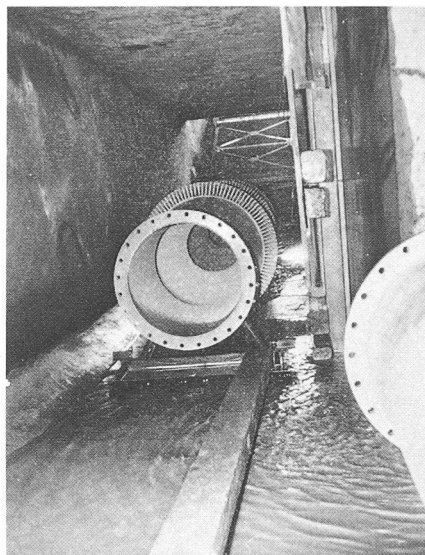
Fig. 10. — Mise en place de la crépine dans l'Usine de la Société des Eaux de l'Arve.
