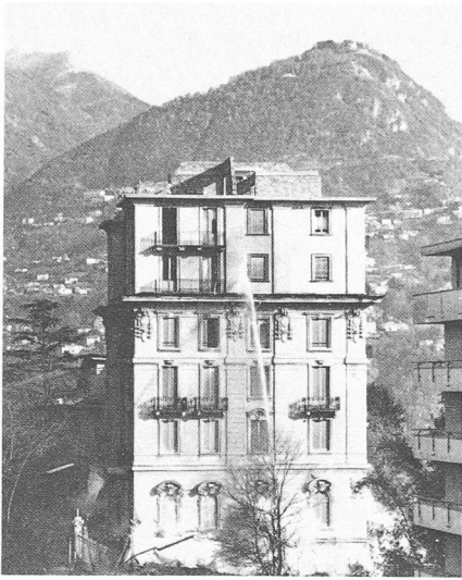
Fig. 2. — 0,4 seconde après la mise à feu. Les ailes de quatre à six niveaux sont en train de tomber (à gauche et à l'arrière). Explosion des charges dans les murs intérieurs du bâtiment de huit niveaux.
