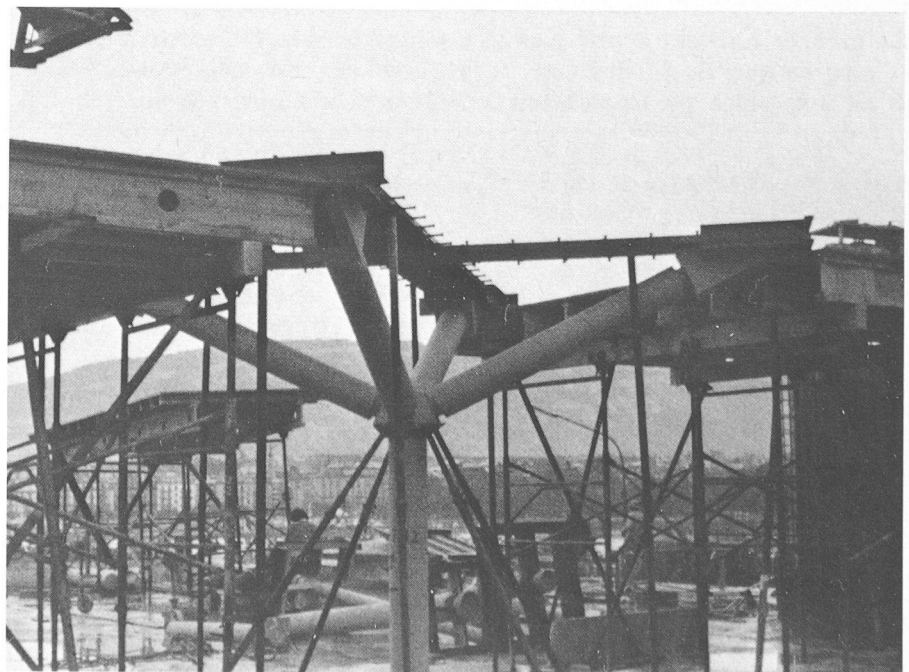
Fig. 4. — Vue d'ensemble d'une colonne en cours de montage.
