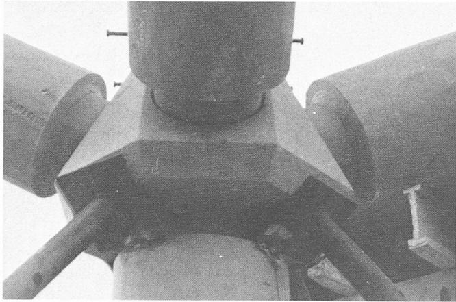
Fig. 2. — « Clé de voûte » en fonte d'acier.
