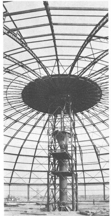
Fig. 7. — Montage à l'aide d'une tour.
