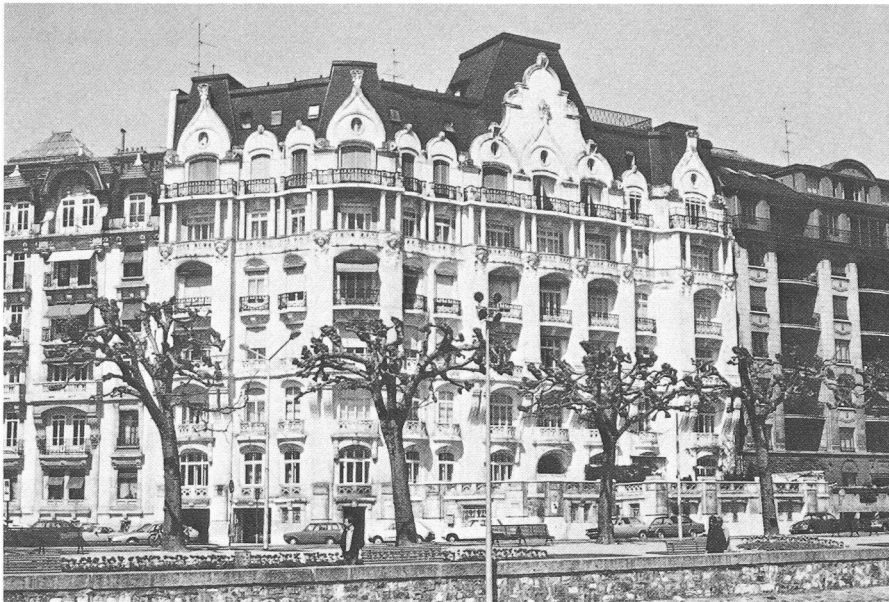
Un bâtiment maintenu : le n° 39 du quai Wilson.
