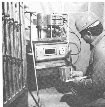
Fig. 11. — Appareillage de lecture à distance.
