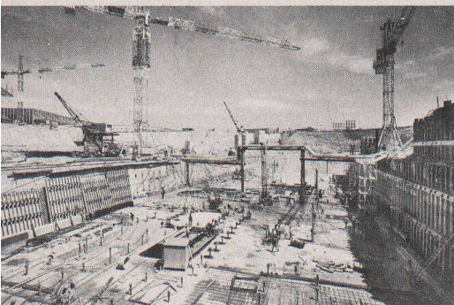
Fig. 14. — La fouille dans le secteur du lot 1, avec un rideau de palplanches ancré dans le terrain. Les têtes des ancrages verticaux émergent de la dalle de fond (ci-dessus).
