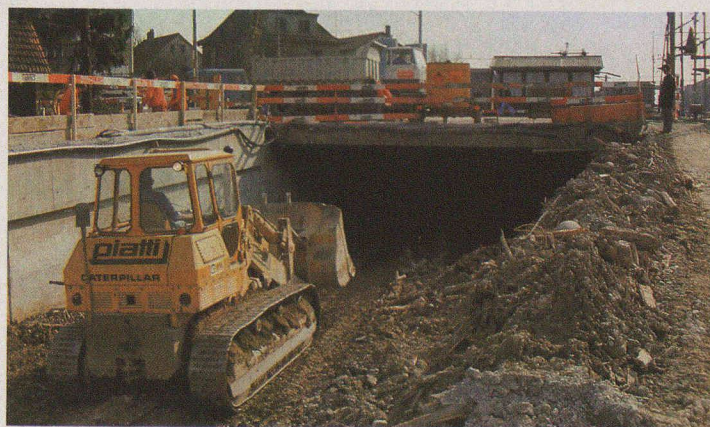
Fig. 26. — Excavation de la future halte d'Opfikon.
