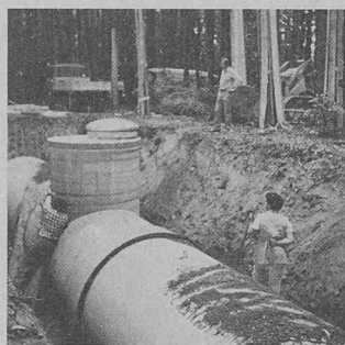
Seulement quelques heures pour la construction d'un réservoir de 45 600 litres
