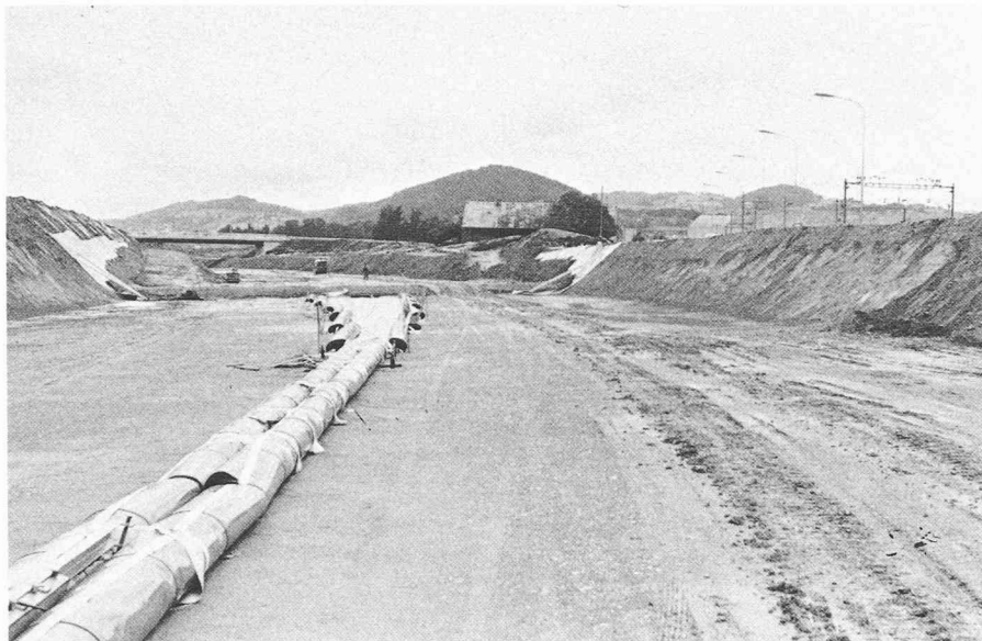
Fig. 7. — Des feuilles d'étanchéité synthétiques déjà posées sur la fondation aplanie. (Photo prise par l'auteur)
