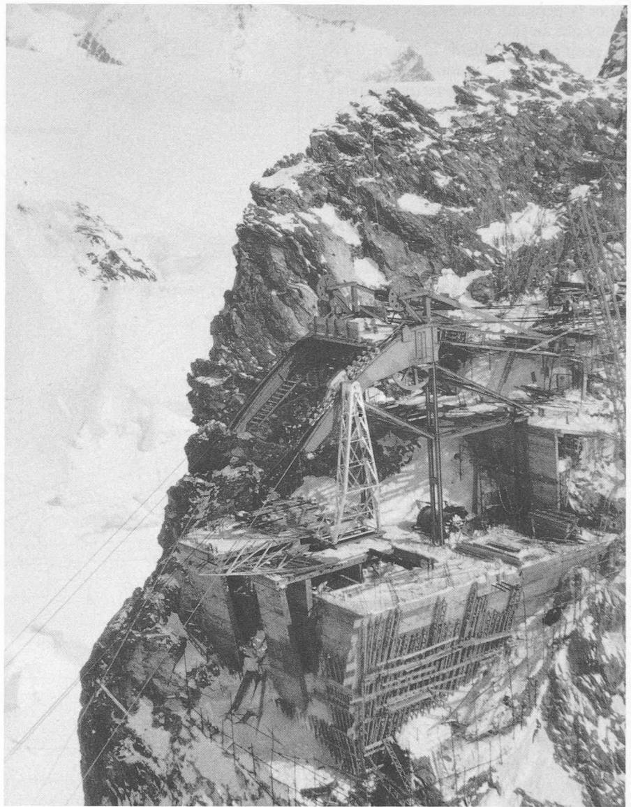
Fig. 5. — Station supérieure pendant la construction.
