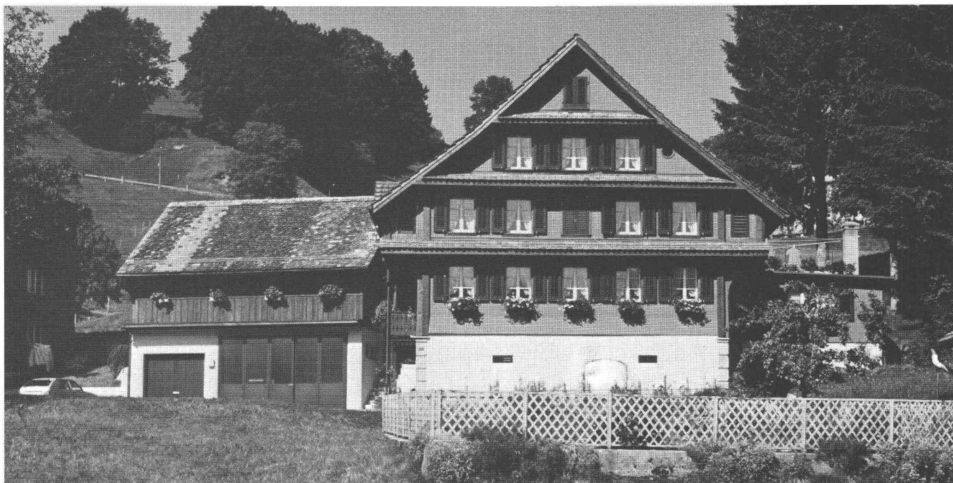
Ferme à Oberägeri, ardoises 7,5 × 30 cm, bardeaux arrondis, brun chevreuil
