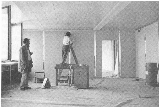
Fig. 10. — Montage des cloisons mobiles.
