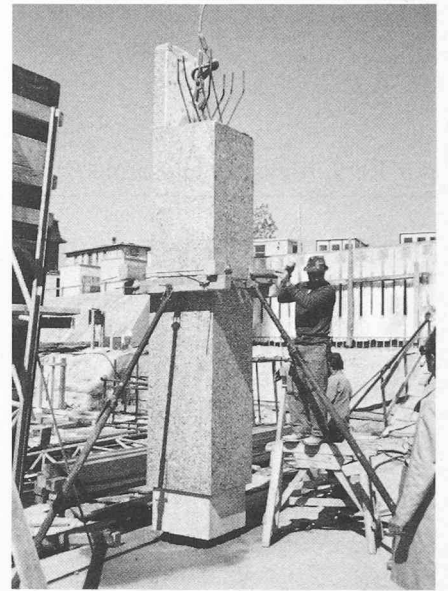
Fig. 16. — Pilier articulé au rez-de-chaussée.
