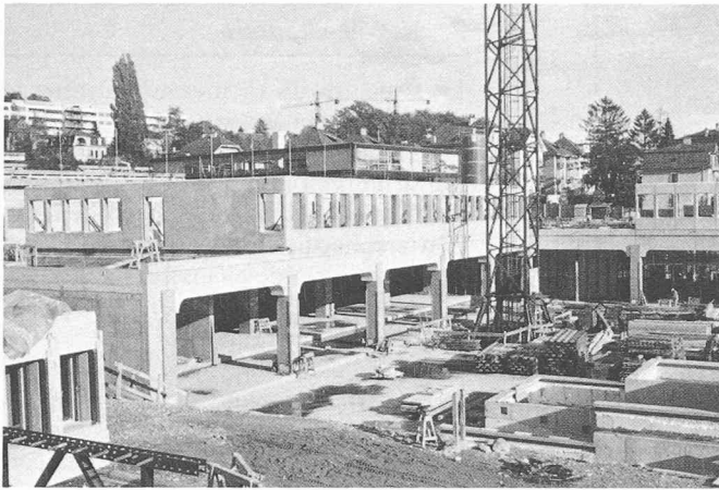
Fig. 8. et 9. — Pose des façades en éléments préfabriqués.
