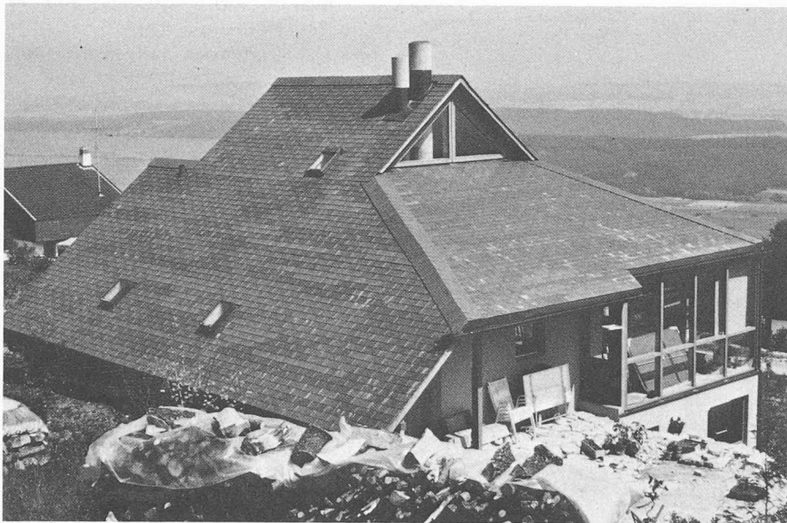
Fig. 3 — Façades ouest et nord.
