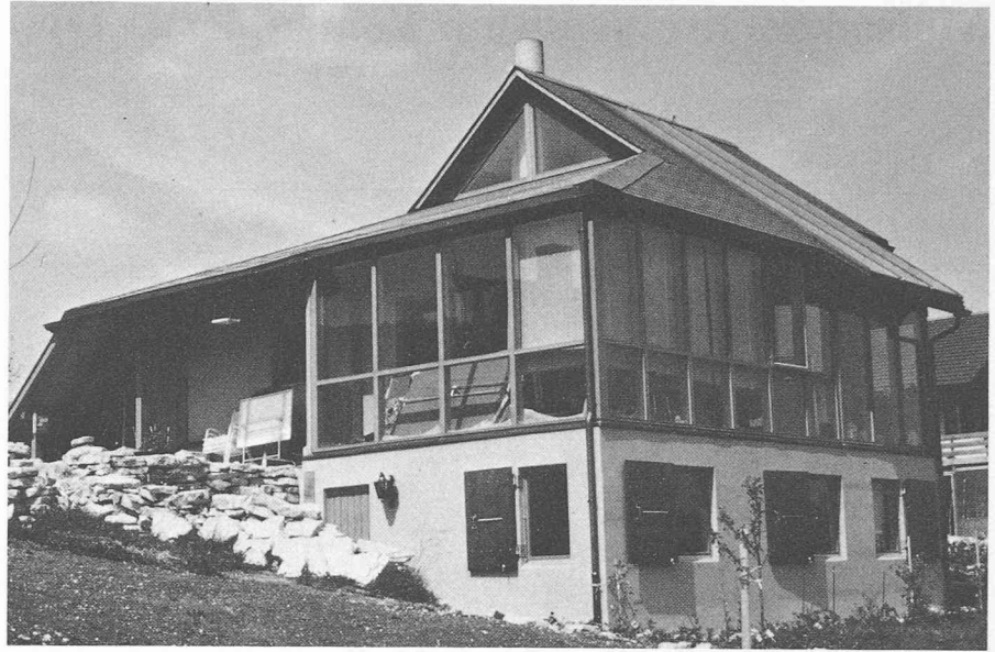
Fig. 2 — Façades sud et ouest.
