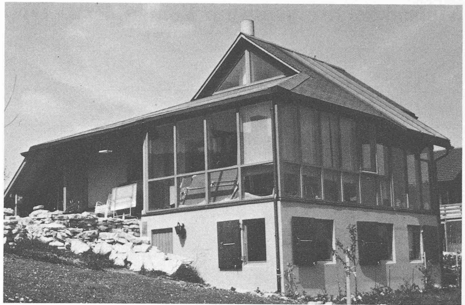
Fig. 2 — Façades sud et ouest.
