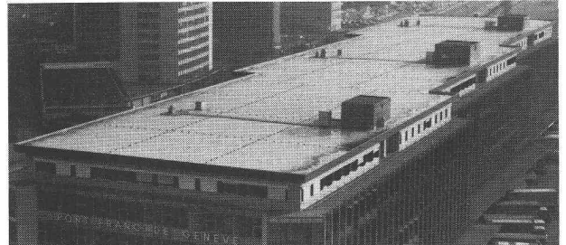
8488 Port-franc, Genève – Architecte: Koechlin René et Mozer Marc, Genève 7'000 m 2 fixés mécaniquement
