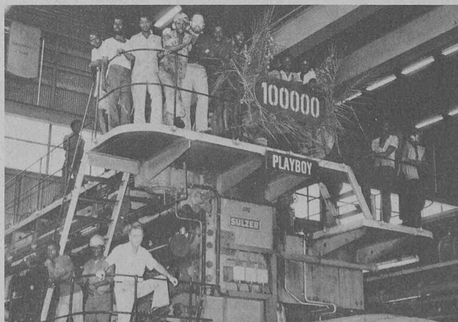
Fig. 2. — Un des moteurs diesel Sulzer 9RF68 à marche lente qui ont été installés en 1965 dans la centrale motrice de 100 MWe à Bong Range. Ce moteur fonctionnant à l'huile lourde a atteint récemment une durée d'exploitation de 100 000 h. de service.
