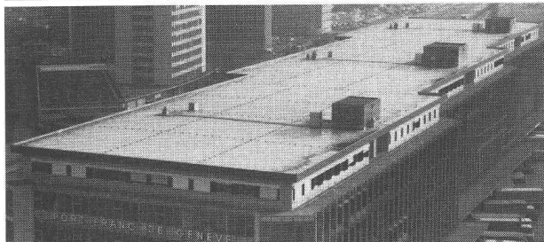
B488 Port-franc, Genève - Architecte: Koechlin René et Mozer Marc, Genève 7'000 m 2 fixés mécaniquement
