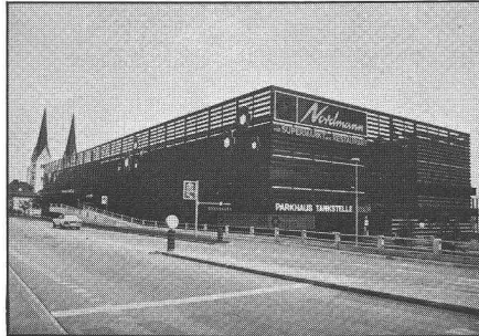
Parking à étages avec accès par rampes
