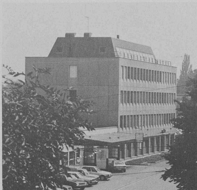
Vue extérieure du bâtiment Sulzer économe d'énergie.
