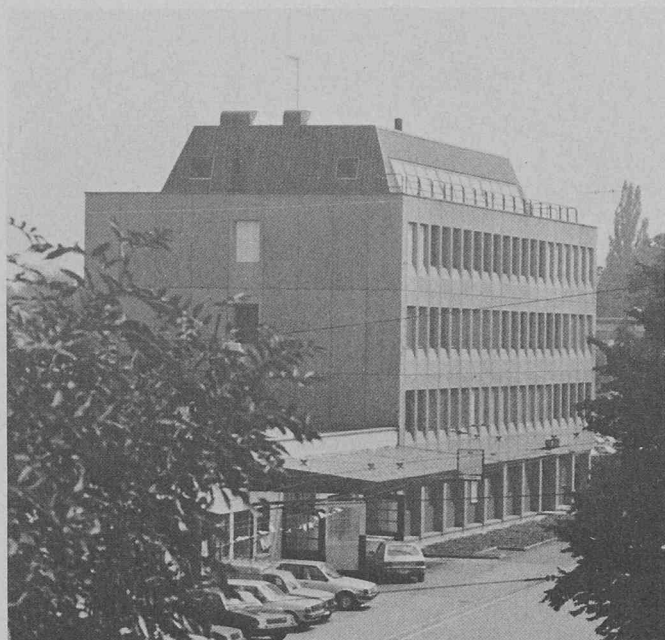
Vue extérieure du bâtiment Sulzer économe d'énergie.
