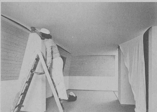
Plafond tendu Bartex , blanc, dans le salon et la salle à manger, la cuisine et la salle de bain (Luwa AG, rénovation d'immeubles, Römeggasse, Schlieren).
