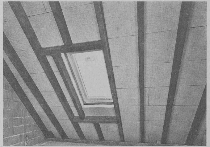
Sous-toiture BI, exécution Nordica, format 200 x 50 cm, montage sur chevron, isolation efficace, sous-toiture et surface visible en un (Maison familiale Schiesser, 5042 Hirschthal).
