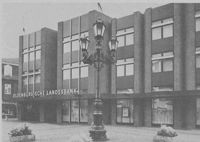
Vue extérieure de la banque où presque 90% des besoins en chauffage sont couverts par une pompe à chaleur.
