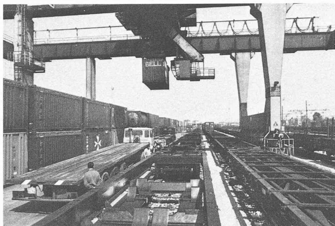
Fig. 8. — Pont roulant de 40 t sur 10 voies de circulation au terminal intermodal de Milan-Rogoredo.
