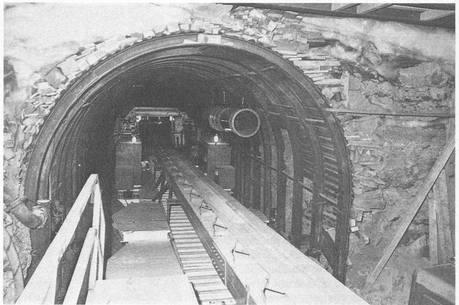
Fenêtre de la galerie d'accès à la station inférieure.
