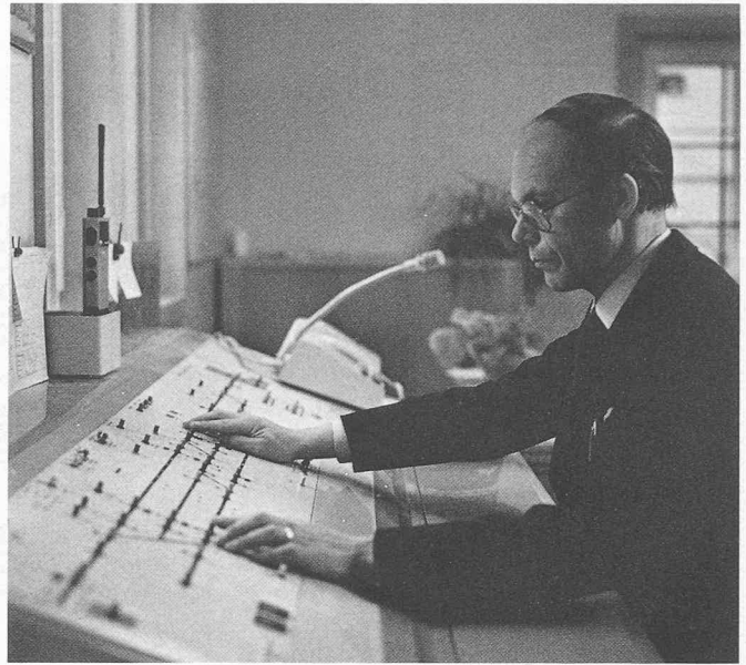
Fig. 5. — Tableau de commande de la gare de Realp.
