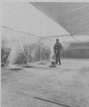
Assainissement d'un sol industriel, notamment avec colmatage des fissures, des trous et des failles. (Photo Rinol Suisse)
