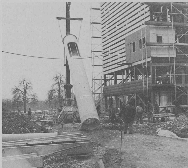
Pose en moins d'une heure: cheminée de fuite en Eternit.
