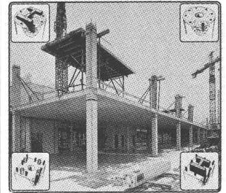
La page de couverture présente un important projet lausannois en voie de réalisation à l'aide de colonnes GRAM (de section carrée) en béton armé centrifugé.
