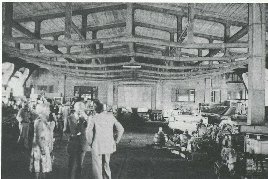
Fig. 2. — La vista dell'interno mostra le travi reticolate in calcestruzzo armato.
