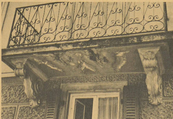
Miracote : assainissement d'un balcon
