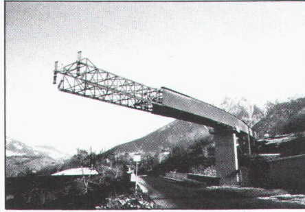
Etape de lancement d'un pont mixte
