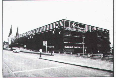
Parking à étages avec accès par rampes
