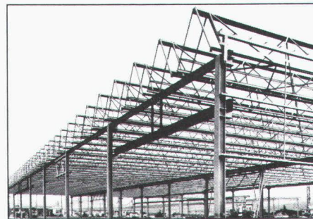
Structure métallique d'une usine – toiture mini-shed –
