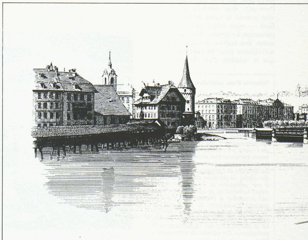
Ce ne sont pas les seuls architectes qui ont modelé le visage de nos villes: pont construit à Lucerne, 1869-
