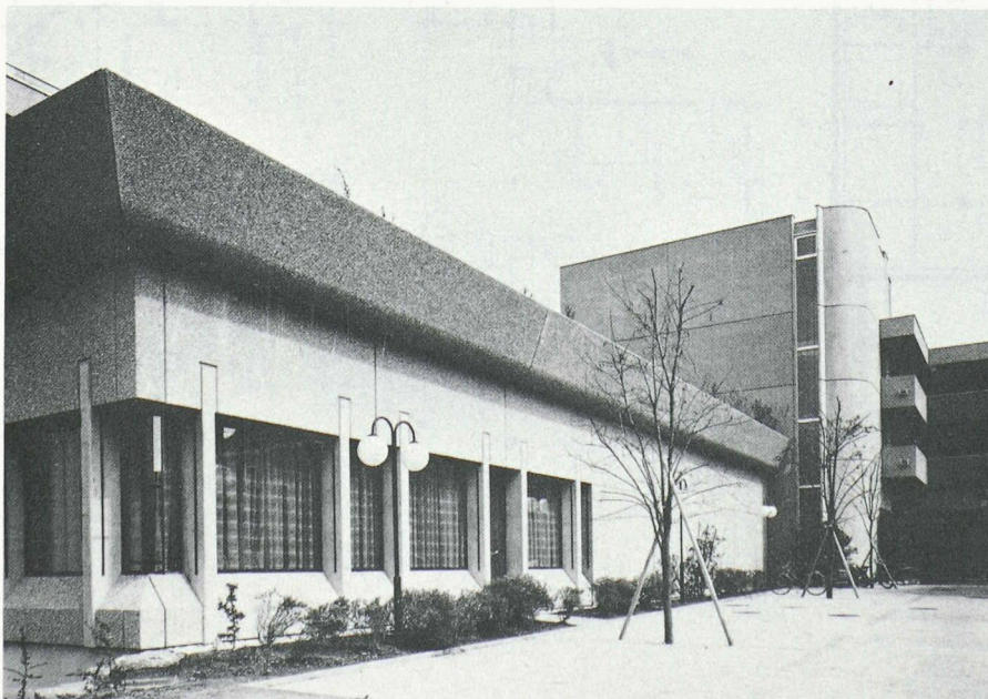
Fig. 1. — Détail de la façade nord-est. Restaurant et place à vélos.
