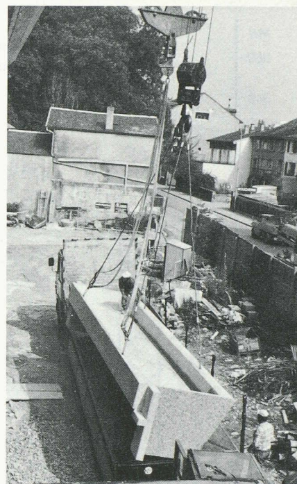
Pose d'un bac à fleurs de l'entrée principale.
