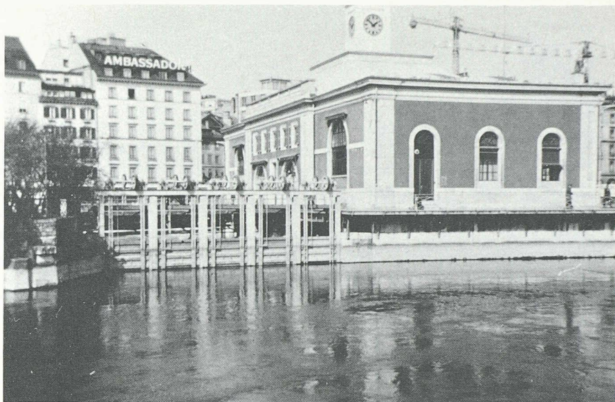
Fig. 5. — Les vannes Séchehay vues du côté du bras droit du Rhône.
