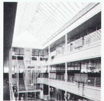
Hewlett-Packard SA Bâtiment administratif à Meyrin - Satigny
