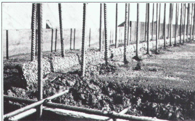
Réalisation d'un joint de reprise en dépit de l'encombrement du ferrailage.
