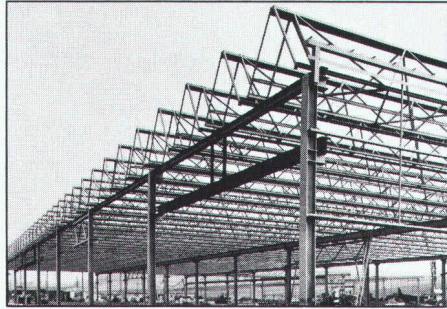
Structure métallique d'une usine - toiture mini-shed -
