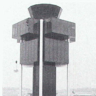
Tour de contrôle Aéroport de Cointrin
