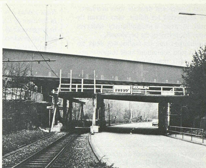
Fig. 13. — Pendant le lancement, les trafics du niveau inférieur sont intégralement maintenus.
