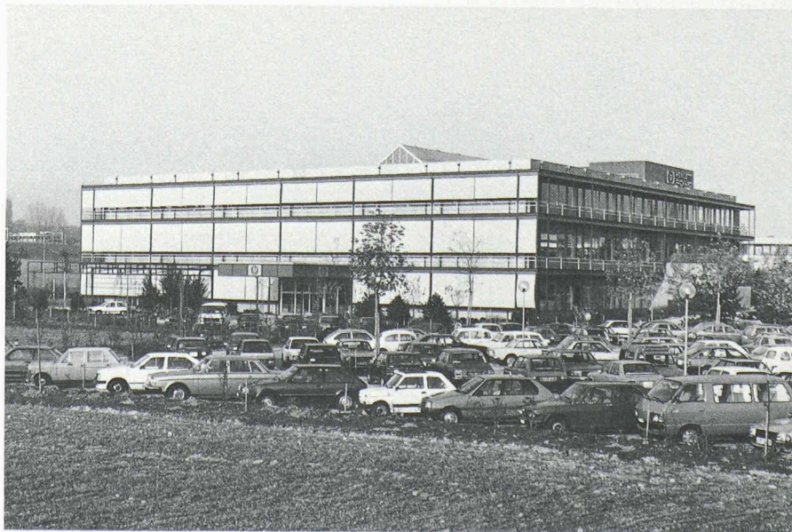
Fig. 2. — Façade sud-ouest, montrant les stores fermés sur les coursives.
