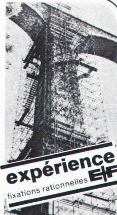
Fixation d'un coffrage
