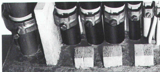
Séparation type VAM-D pour traversées de plafonds
