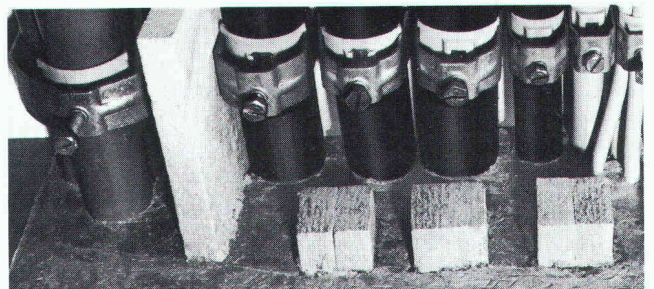
Séparation type VAM-D pour traversées de plafonds
