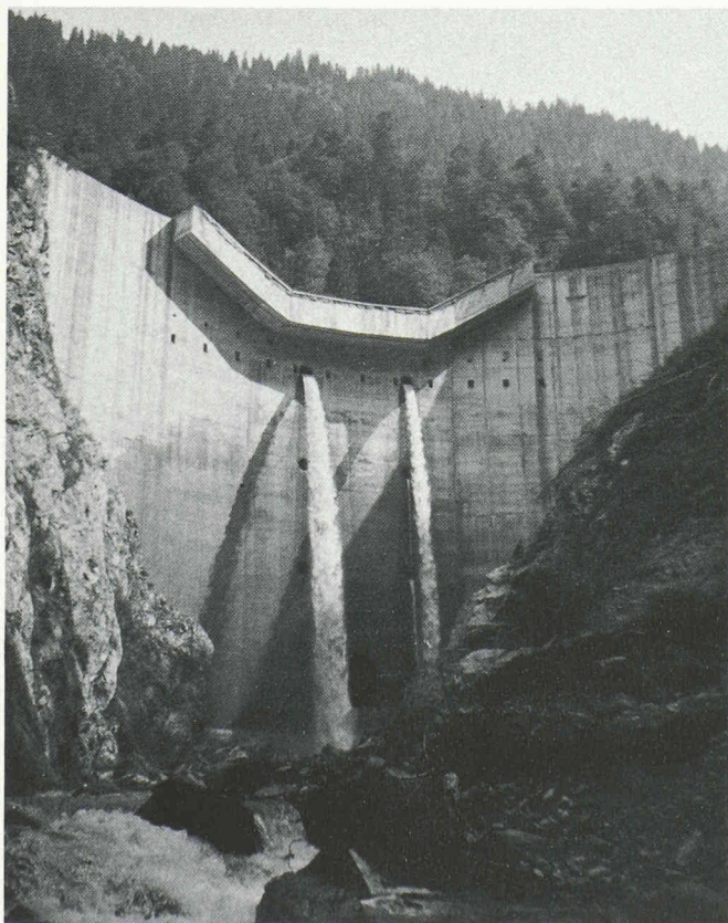
Fig. 20 — Vue du barrage B sur le Saint-Barthélemy.
