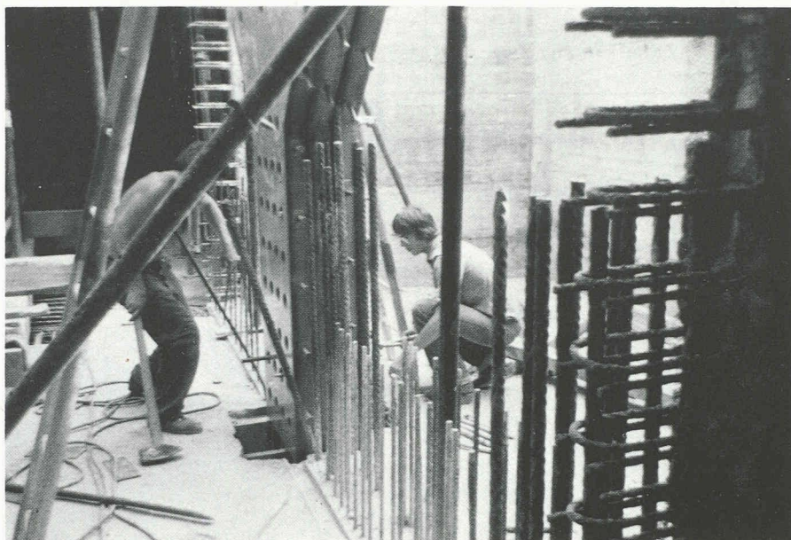
Fig. 10. — Boulonnage des tiges filetées.
