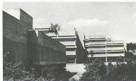
2422 Zollikofen 1962-66 Schulhausstrasse 30, Arch. Mäder und Brüggemann
