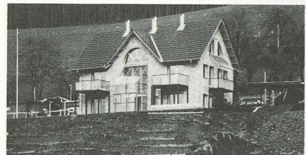
2312 Gümliigen 1984 Einfamilienhaus Furrer, Arch. Althaus Jürg
