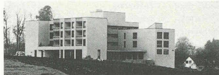
2410 Münchenbuchsee 1978-79 Altersheim, Arch. Hebeisen und Vatter
