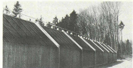
0197 Niesen 1930/1940-50/1960 Lawinerverbauung zugunsten Aufforstung (wird später ausführlicher gezeigt)
