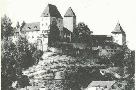
8126 Burgdorf 1974-83 Schlossfelssanierung nach denkmalpflegerischen Anforderungen Assainissement de roches au château selon les critères de la protection des monuments et sites, Ing. Steiner + Buschor AG, Publ. Bericht Kt. Baudirektion 5/1984
