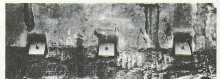
3204 Bern 2, Enge 1984 Bedag: 22 m tiefe Baugrube in Molasse, Engenthalstrasse, Ing. Weber + Brönnimann AG
