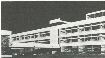
3121 Bern 5, Breitenrain 1958-59/71 Sekundarschule Wankdorf und Ergänzungsbau Ingenieurschule, Sempachstrasse, Arch. Mäder und Brüggemann
