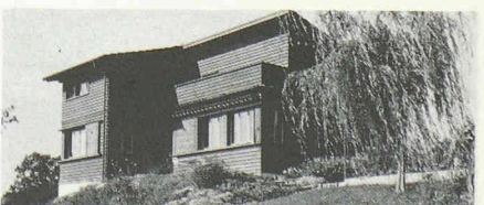
2100 Bolligen 1934 Einfamilienhaus, Arch. Jenny M.
