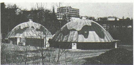
3161 Bern 3, Marzili 1971 Jugendzentrum «Gaskessel», auf Gasometerfundamenten, Gaswerkareal, Arch. Städt. Hochbaumt
