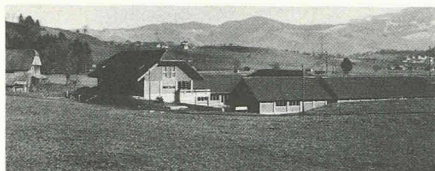
0240 Reutigen 1980/81 Kant. Fischzuchtanstalt, Arch. Baeriswyl Pierre
