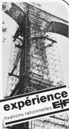
Fixation d'un coffrage
