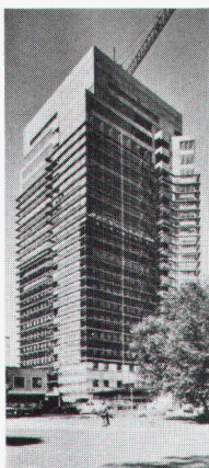
Revêtement de façade
