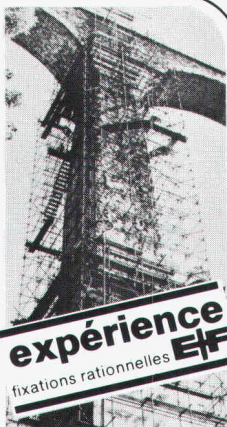
Fixation d'un coffrage
