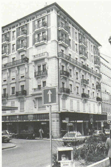
Fig. 8. — Rehaussement d'un immeuble à la rue du Cendrier.
