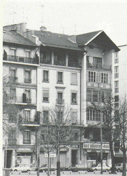
Fig. 5. — Bâtiments construits au début du XX e siècle (avenue Henri-Dunant). On remarque l'expression du couronnement.
