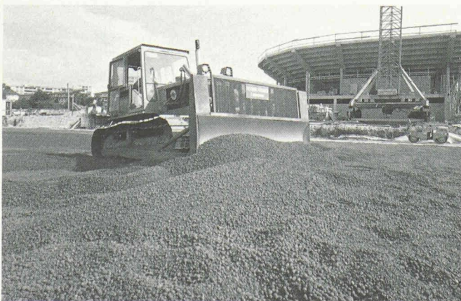
Fig. 11. — Mise en place du LECA.
