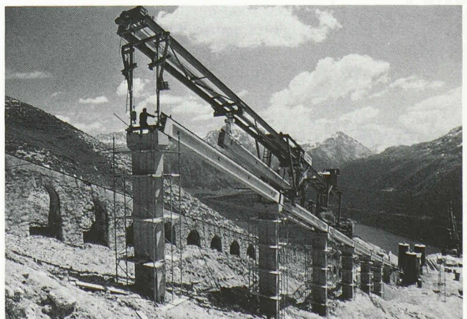
Montage des poutres longitudinales en béton d'un poids de 8 t à l'aide d'une installation de montagne spéciale. Au fond, le tracé de l'ancien chemin de fer du Corviglia.
