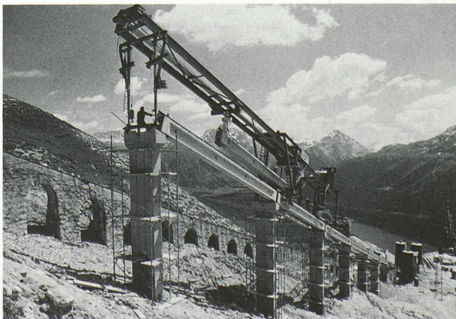
Montage des poutres longitudinales en béton d'un poids de 8 t à l'aide d'une installation de montagne spéciale. Au fond, le tracé de l'ancien chemin de fer du Corviglia.
